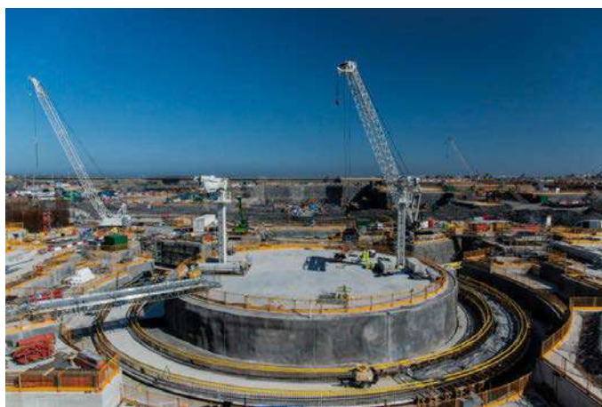
図 3-1 建設中のヒンクリーポイント C 原子力発電所
